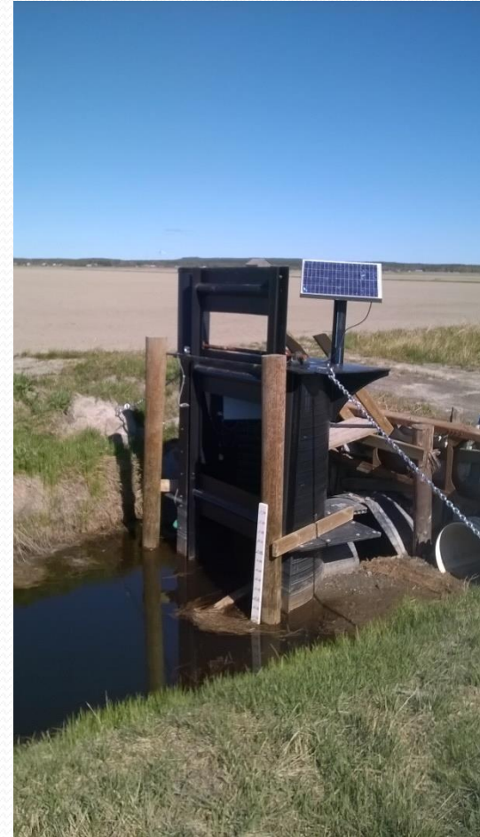
Valtaojan padotus Söderfjärdenillä Kuva: Rainer Rosendahl
